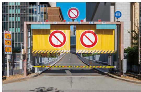
入口遠隔閉鎖装置（中之島入口）
