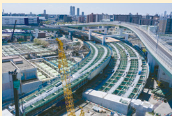
橋梁架設工(海老江地区)
