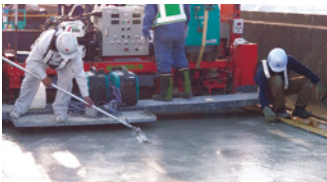
SFRC舗装施工
