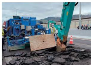
IH式鋼床版舗装撤去工法による舗装撤去
