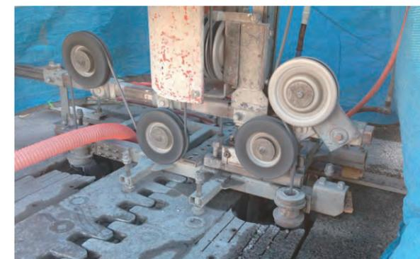
低騒音伸縮継手撤去工法（SJS工法）
