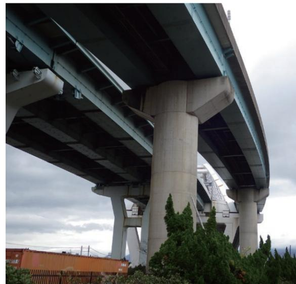
一般県道芦屋鳴尾浜線に架かる橋梁の耐震補強設計
