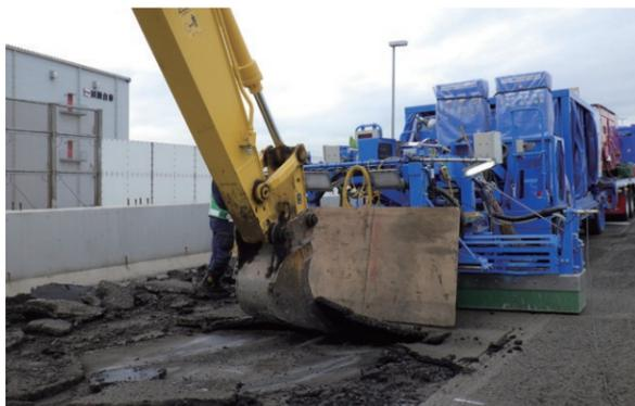
IH式鋼床版舗装撤去工法による舗装撤去
