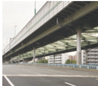
ロックンギ橋脚
