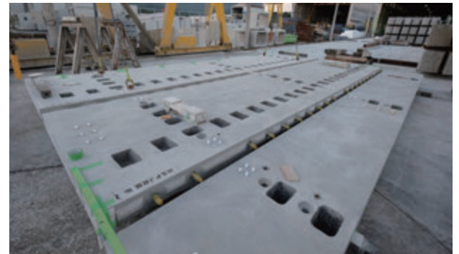
HSプレストレスジョイントを配置した新設床版
