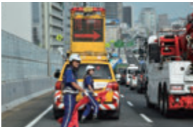
交通規制による落下物の回収
