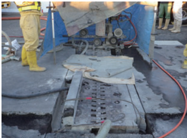
SJS工法によるジョイントの撤去
