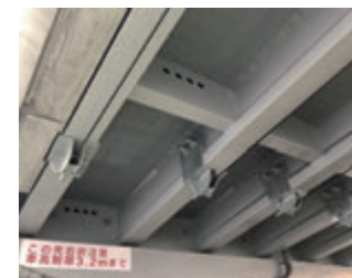
PC桁の外ケーブル補強
