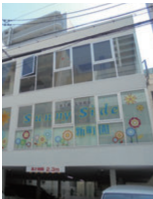
フィル・パークHS新町（駐車場＋空中店舗）
