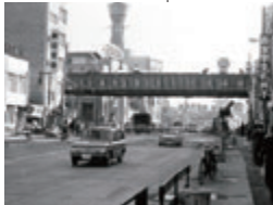
建設中の1号環状線
