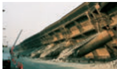
阪神・淡路大震災の被害
