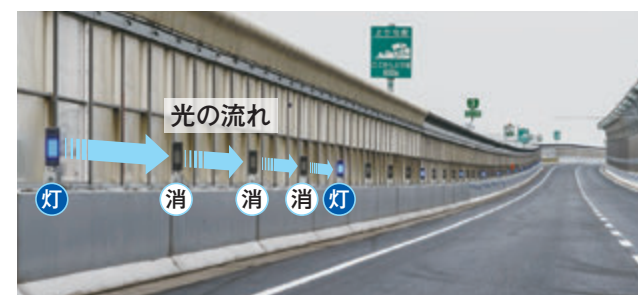
3号神戸線(東行き)深江サグ付近に設置した速度回復誘導灯
