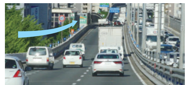
13号東大阪線(東行き)森之宮付近に設置した速度回復誘導灯
