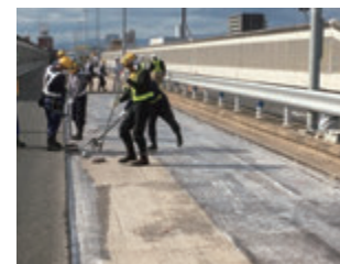
高性能床版防水
