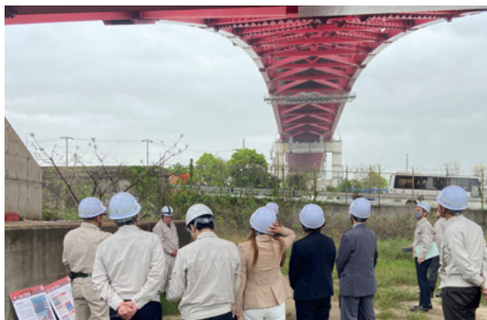
現場視察の様子
