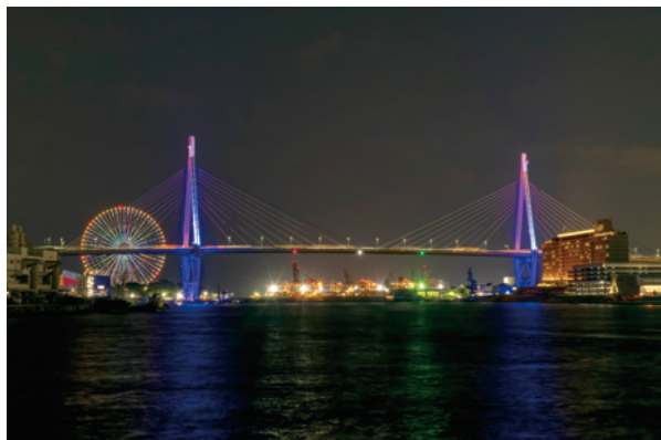
天保山大橋(5号湾岸線)
