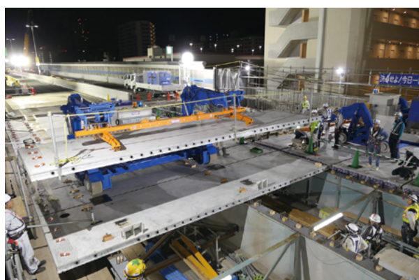
ソーシャルロス軽減に資する技術開発 (超高強度繊維補強コンクリート(UFC)床版)
