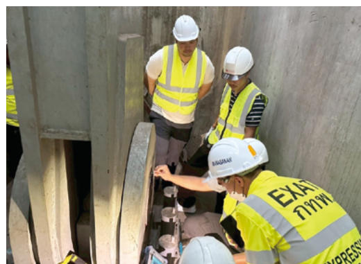
ASIAM Infraが受注した橋梁点検業務の実施状況
