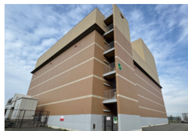
南島換気所(6号大和川線)
