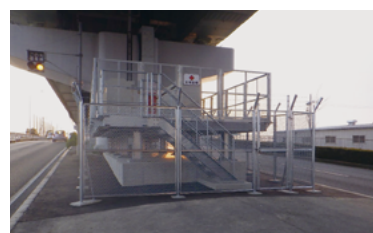
変電塔のかさ上げ
