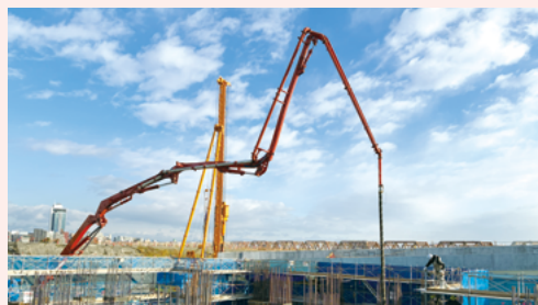
豊崎受電所躯体工事(豊崎地区)
