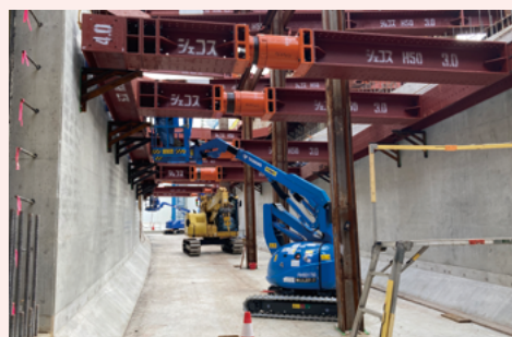
開削トンネル工事(駒栄工区)
