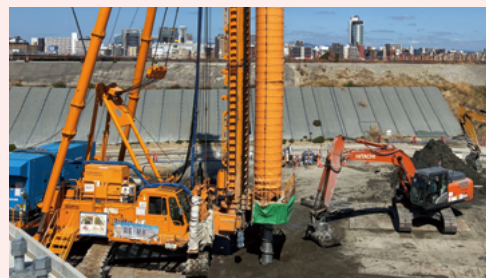
地盤改良工(豊崎地区)
