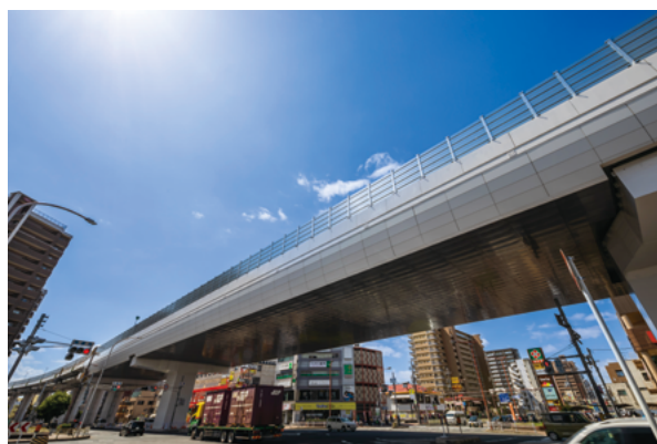
架替え完了後
