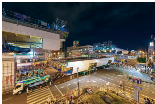
中央径間部の架設状況
