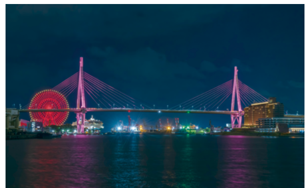
天保山大橋(5号湾岸線)
