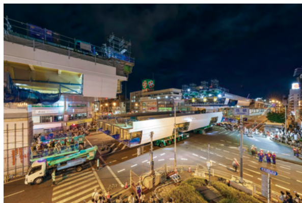
中央径間部の架設状況
