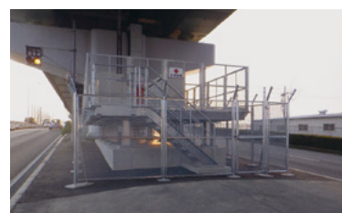
変電塔のかさ上げ
