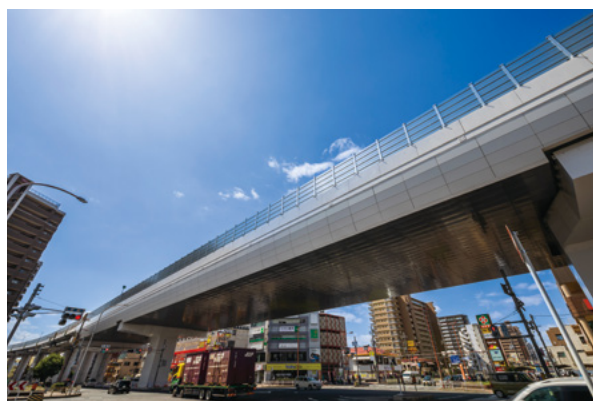
架替え完了後
