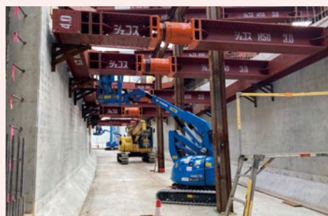
開削トンネル工事（駒栄工区）
