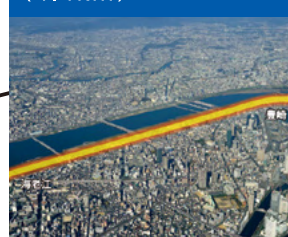
淀川左岸線延伸部 (8.7km)
