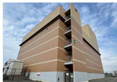
南島換気所(6号大和川線)
