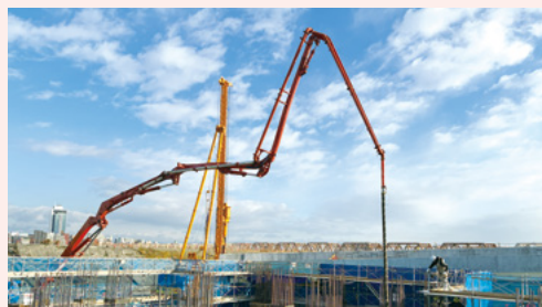
豊崎受電所躯体工事(豊崎地区)
