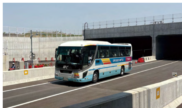
淀川左岸線(2期)区間を通行する駅シャトルバス
