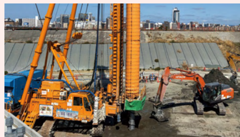
地盤改良工(豊崎地区)
