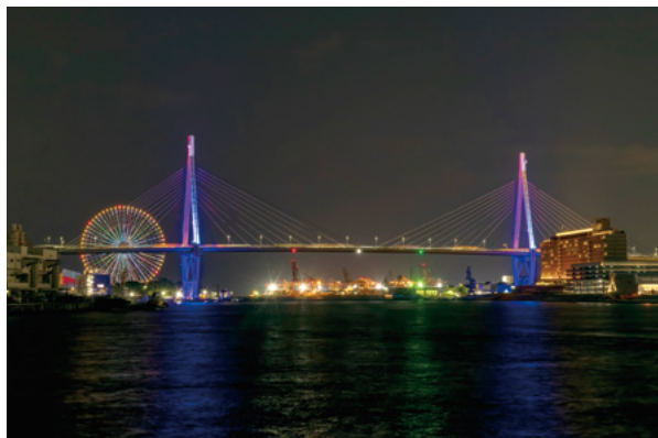
天保山大橋(5号湾岸線)
