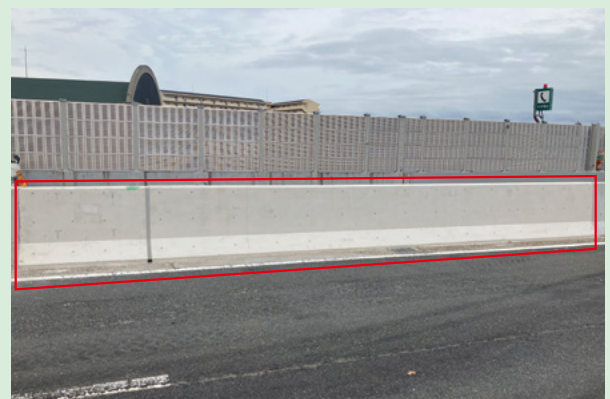
中央分離帯部への低炭素コンクリートの試験施工
