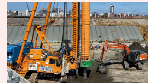
地盤改良工(豊崎地区)
