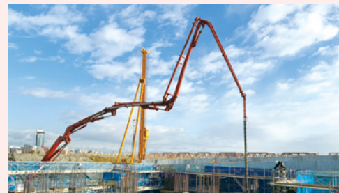
豊崎受電所躯体工事(豊崎地区)
