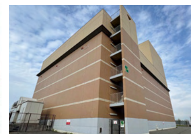
南島換気所（6号大和川線）
