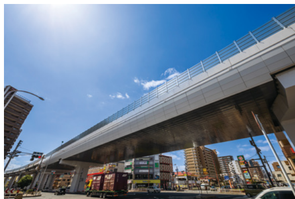
架替え完了後
