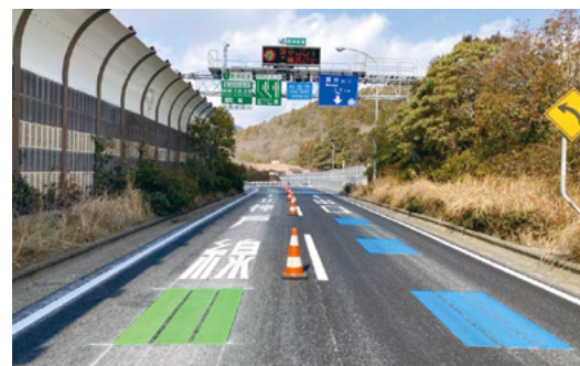
32号新神戸トンネル 箕谷JCT／出口分岐におけるカラー舗装状況
