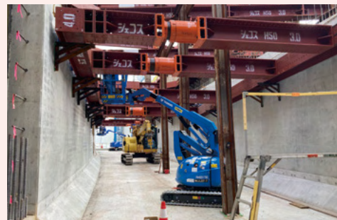
開削トンネル工事(駒栄工区)
