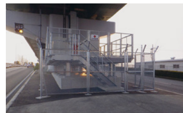
変電塔のかさ上げ
