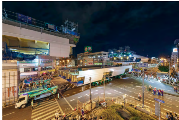
中央径間部の架設状況
