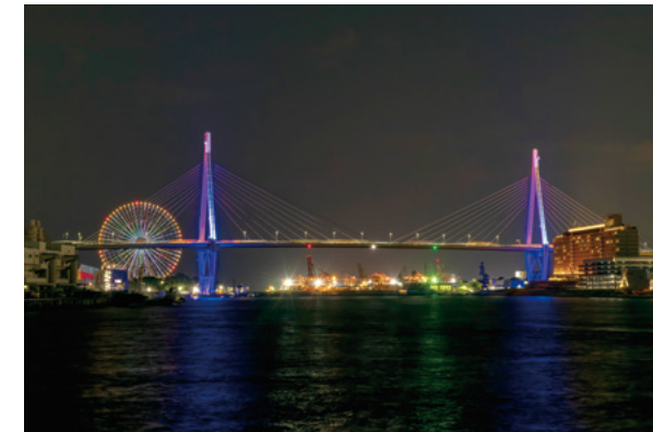
天保山大橋(5号湾岸線)
