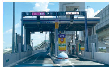
淀川左岸舞洲料金所
