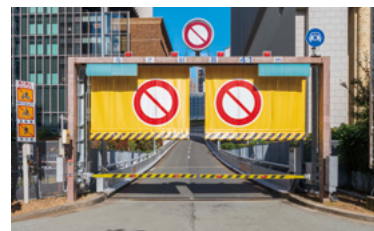
入口遠隔閉鎖装置
