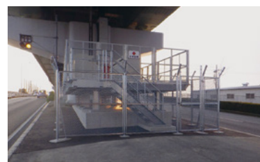
変電塔のかさ上げ
