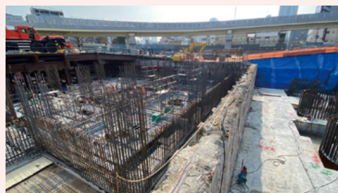
豊崎受電所躯体工事(豊崎地区)
