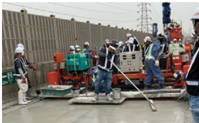
SFRC舗装の施工状況
