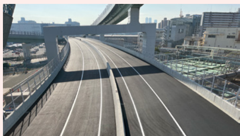
舗装工(海老江地区)
