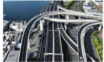
工事完了後(4号湾岸線助松JCT)
