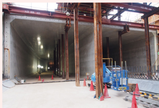
開削トンネル工事(駒栄地区)
