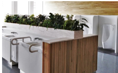
改修後のトイレ(泉大津PA)
