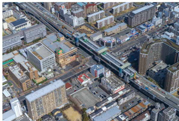
14号松原線喜連瓜破大規模更新工事
