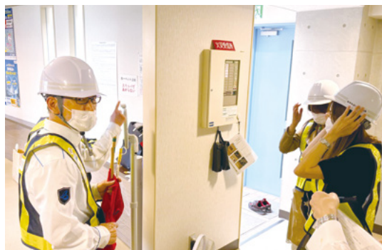
現場視察の様子
