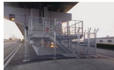
変電塔のかさ上げ
