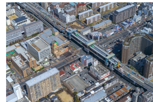
14号松原線喜連瓜破橋大規模更新工事
