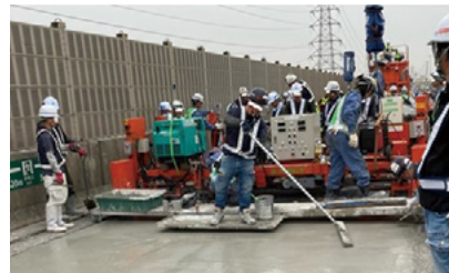
SFRC舗装の施工状況
