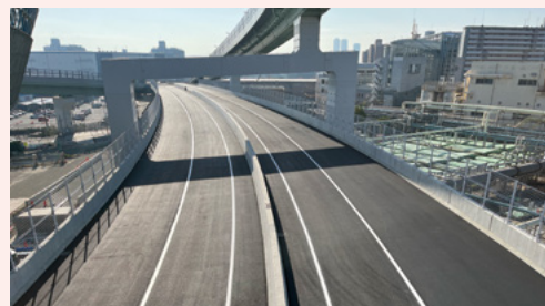
舗装工(海老江地区)
