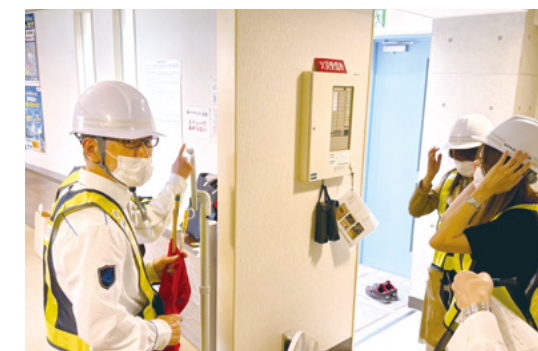
現場視察の様子
