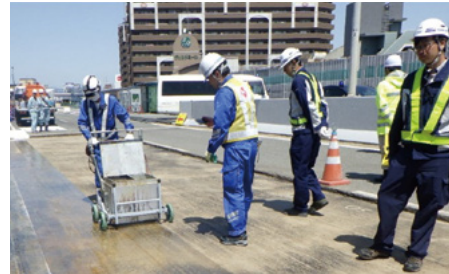
「床版防水材料に関する共同研究」における試験施工
