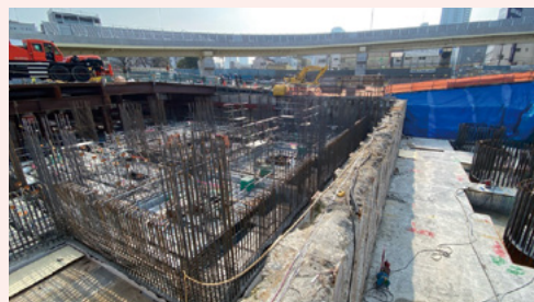
豊崎受電所躯体工事(豊崎地区)
