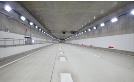
LED化された道路照明
