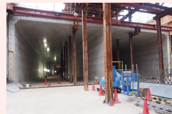
開削トンネル工事(駒栄地区)
