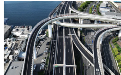
工事完了後(4号湾岸線助松JCT)
