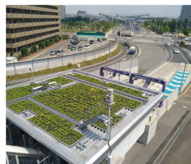
2号淀川左岸線大開料金所
