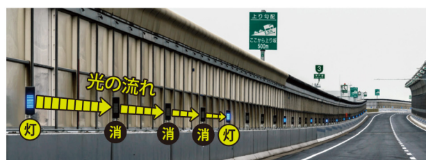
3号神戸線上り深江付近に設置した速度回復誘導灯
