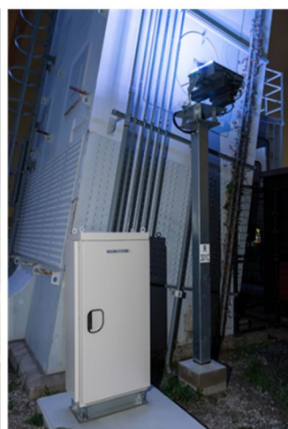
写真-3.3 主塔下部(支柱への設置)
