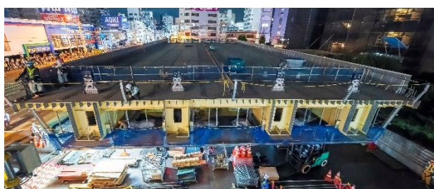
写真-15 組立て完了後の中央径間部
