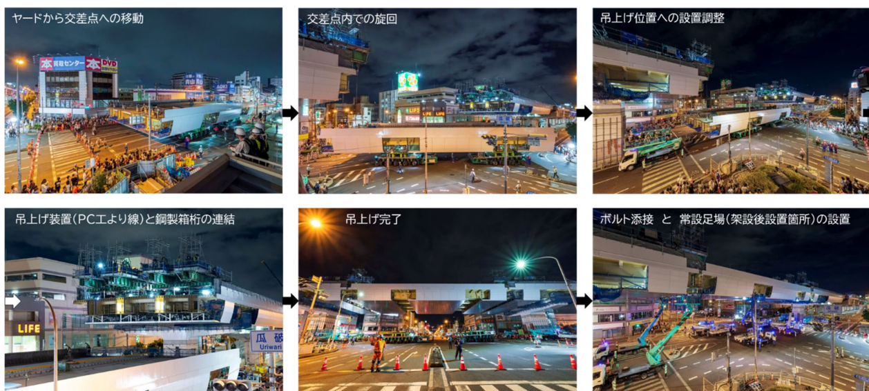
写真-16 中央径間部の鋼製箱桁の吊上げ架設の流れ
