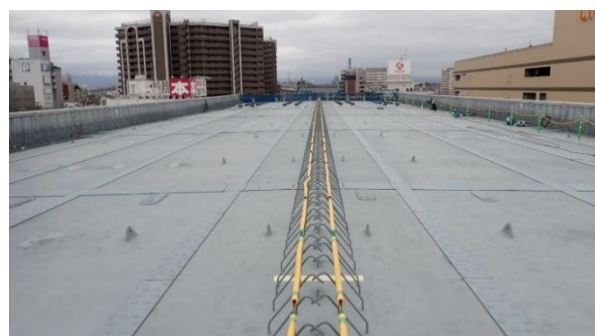
写真-18 鋼床版面上の添接部
