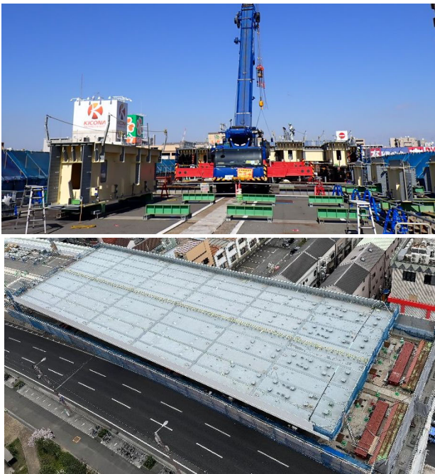
写真-11 既設橋梁上での地組立て （上:組立て中, 下:組立て完了）
