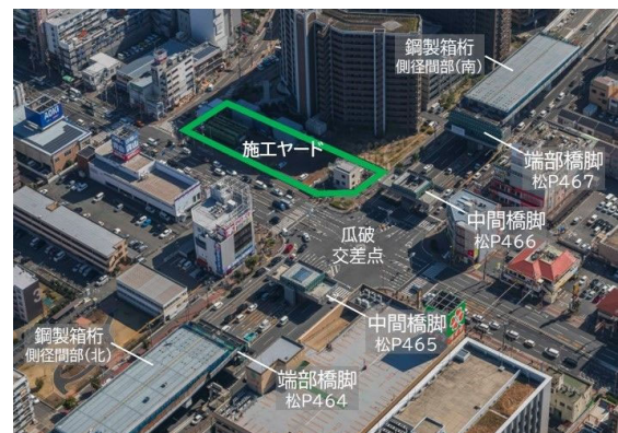
写真-2 瓜破交差点と施工ヤード
