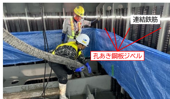
写真-9 鋼製梁内部の孔あき鋼板ジベル (剛結コンクリート打設中)
