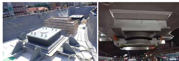
写真-20 免震支承（左）と鋼製支承（右）
