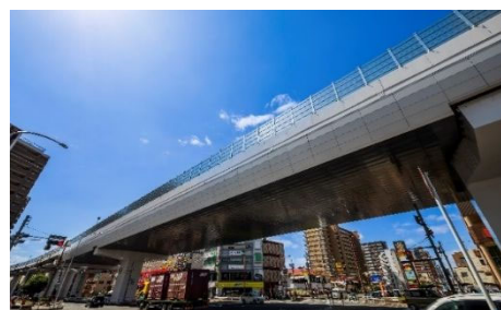
写真-1 架替え後の喜連瓜破橋
