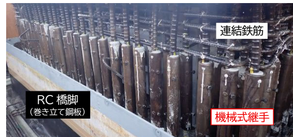
写真-8 機械式継手 (モルタル充填継手)
