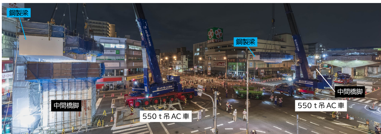
写真-4 鋼製梁のクレーン一括架設
