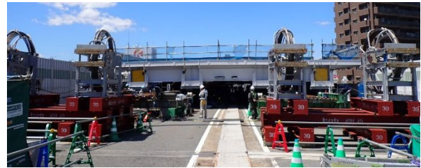
写真-12 おしめ設備
