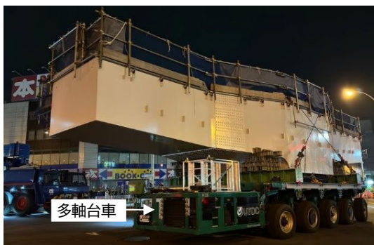
写真-3 鋼製梁の運搬
