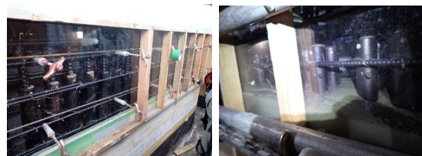
写真-10 透明型枠部 (左:打設前 右:打設中)
