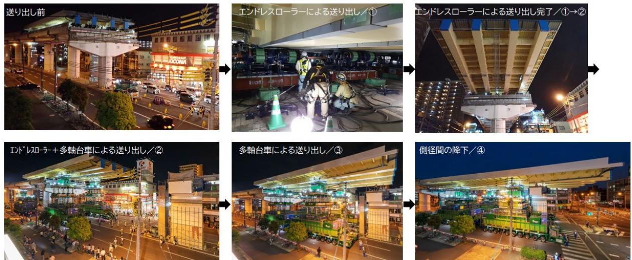
写真-13 側径間部の鋼製箱桁の送り出し架設の流れ
