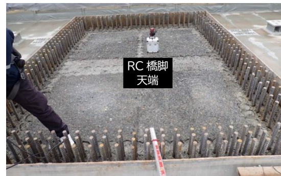
写真-7 RC 橋脚の主鉄筋
