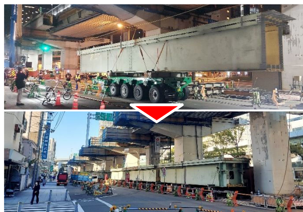
写真-4 撤去桁の高架下への移動
