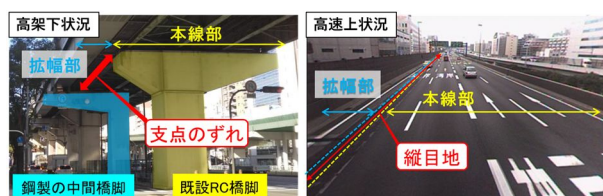
写真-1 本線部と拡幅部（改築前）
