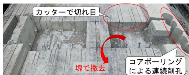
図-14 騒音対策後のコンクリート撤去跡
