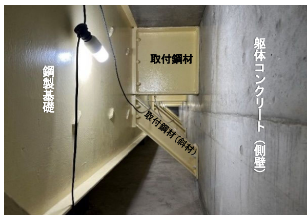
写真-4 維持管理用空間
