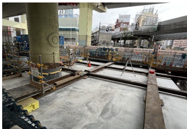
写真-3 躯体コンクリート外観（頂版）
