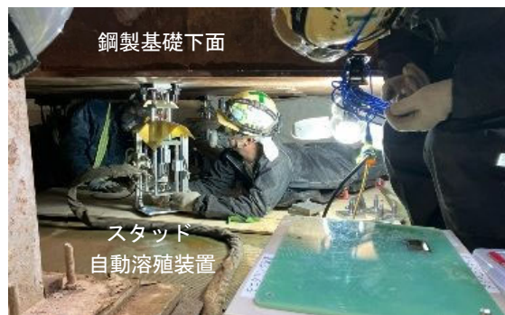
写真-2 鋼製基礎下面への高力スタッドボルト溶接状況（上向き）
