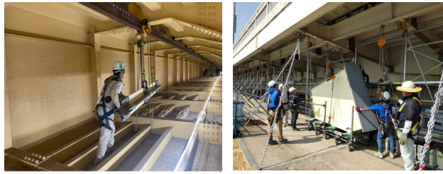
(a) 内部 (b) 外部 写真-5 補強部材の運搬設備
