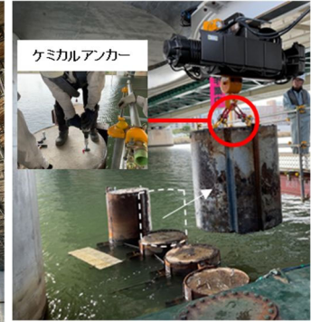
写真-3 テルハクレーンを用いた鋼管矢板切断撤去 (梁下のみ)
