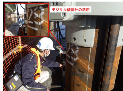
写真-1 鋼管矢板の鉛直精度管理 (例：デジタル傾斜計)
