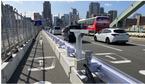
写真-6 常設1車線規制による仮歩道
