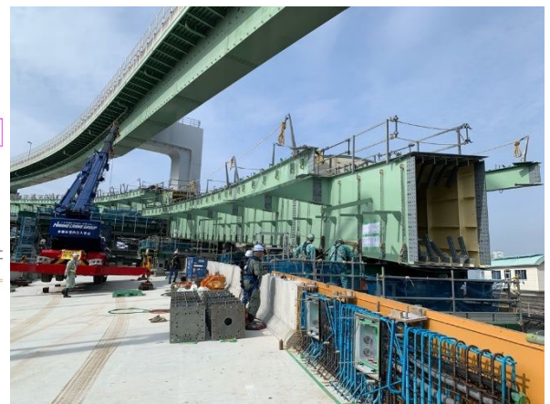
写真-7 ジャッキアップ架設状況
