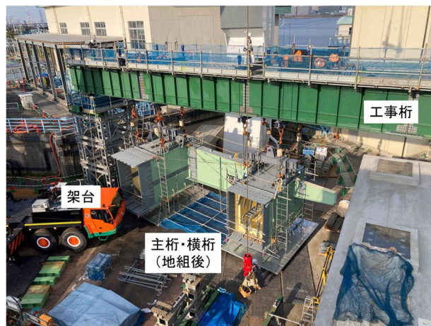
写真-2 工事桁地組状況
