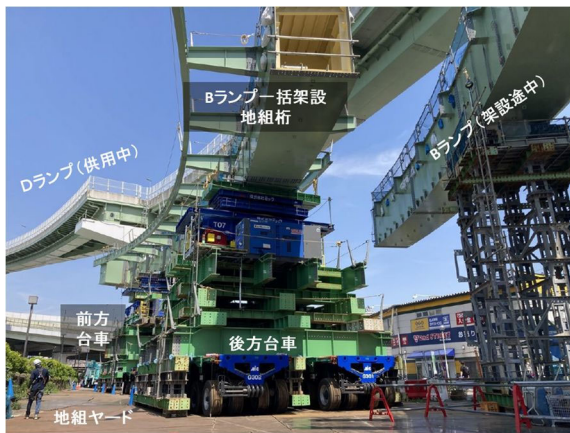
写真-3 多軸台車上での桁地組状況
