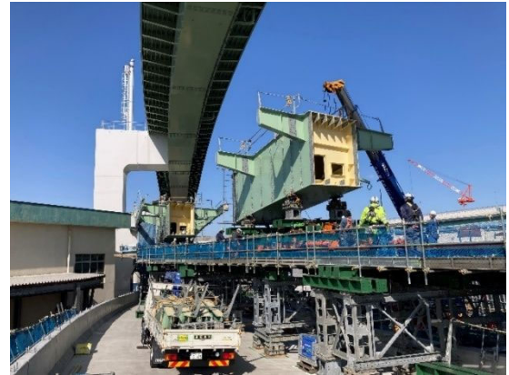
写真-5 縦送り架設状況
