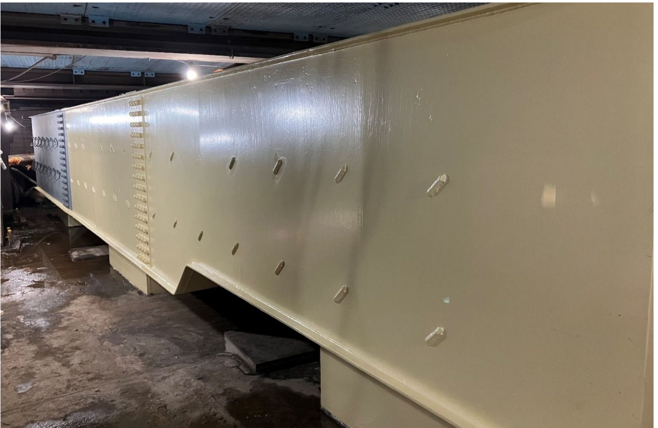
防食工完了後の鋼製基礎外面状況（PN-01）
