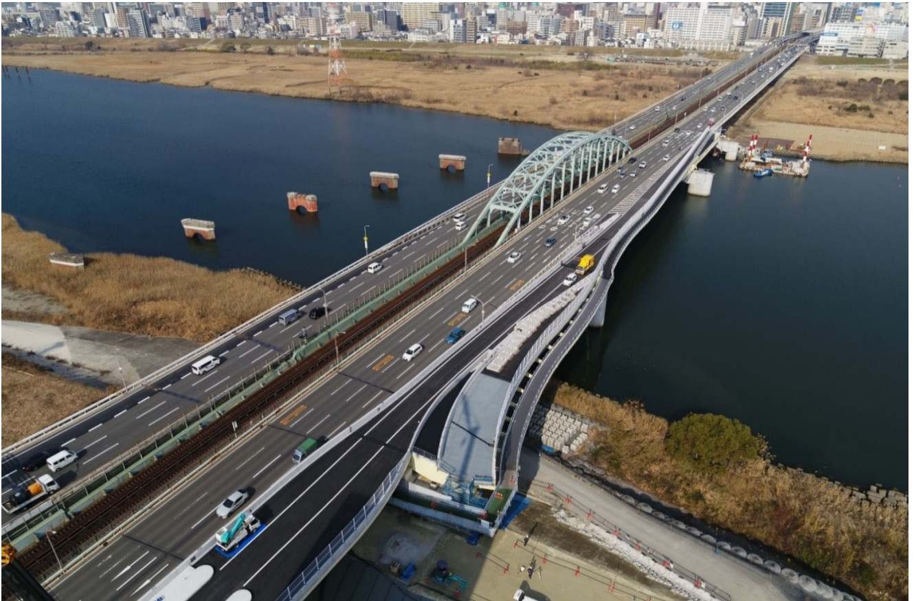
豊崎IC（仮称）オンランプ橋梁（河川内部）
