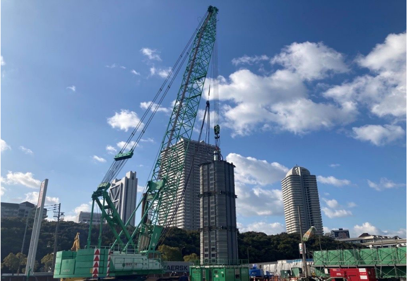
騒音防止装置を使用した橋脚基礎（鋼管矢板）の施工状況（六甲アイランド工区）
