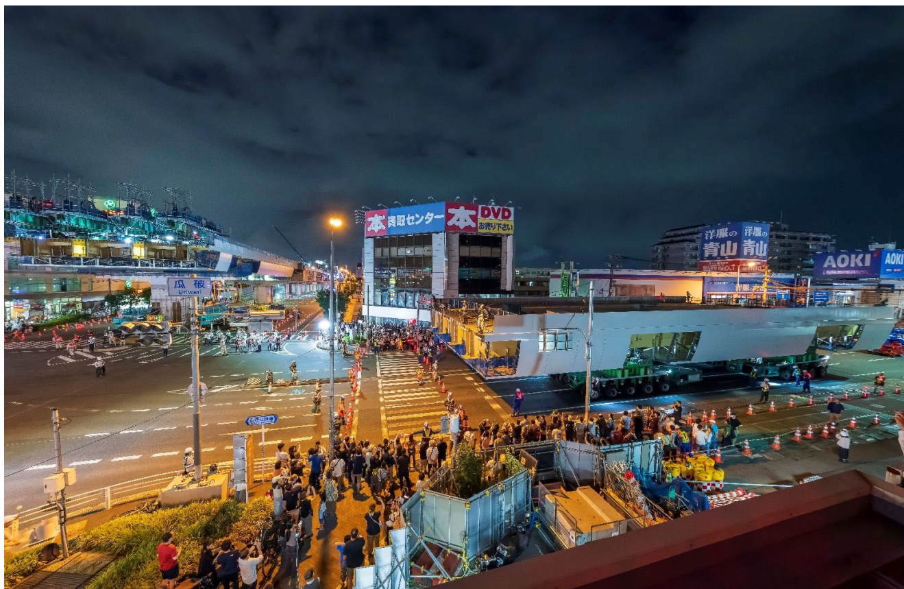
鋼製箱桁（中央径間部）の運搬
