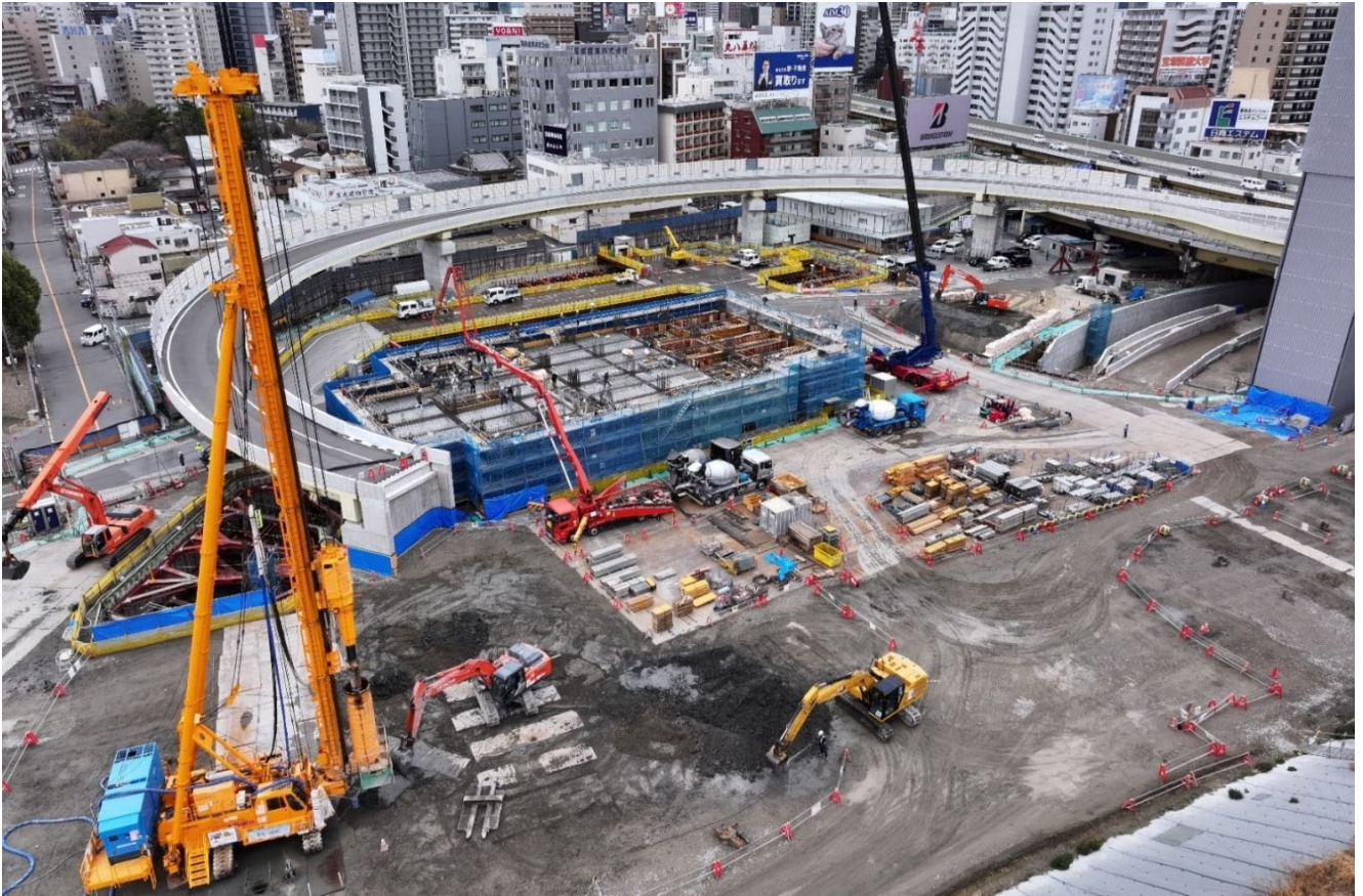
豊崎受電所と本線HB-1～HB-4区間（淀川左岸線2期との接続部）施工状況
