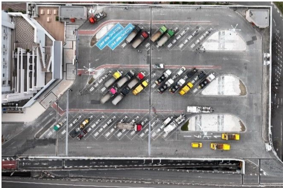
泉大津PA（陸側）施工前
