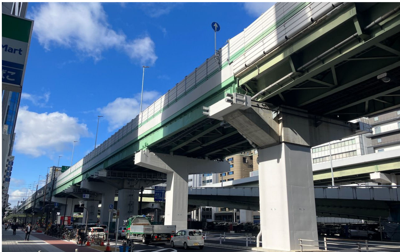
改築後（高架下）
