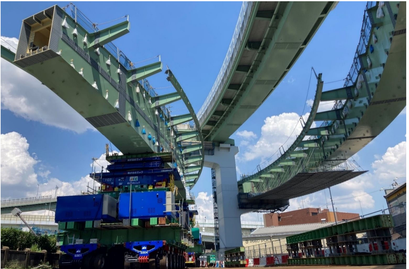
海老江ジャンクションBランプ(淀川左岸線2期→3号神戸線) 架設桁の多軸台車による移動
