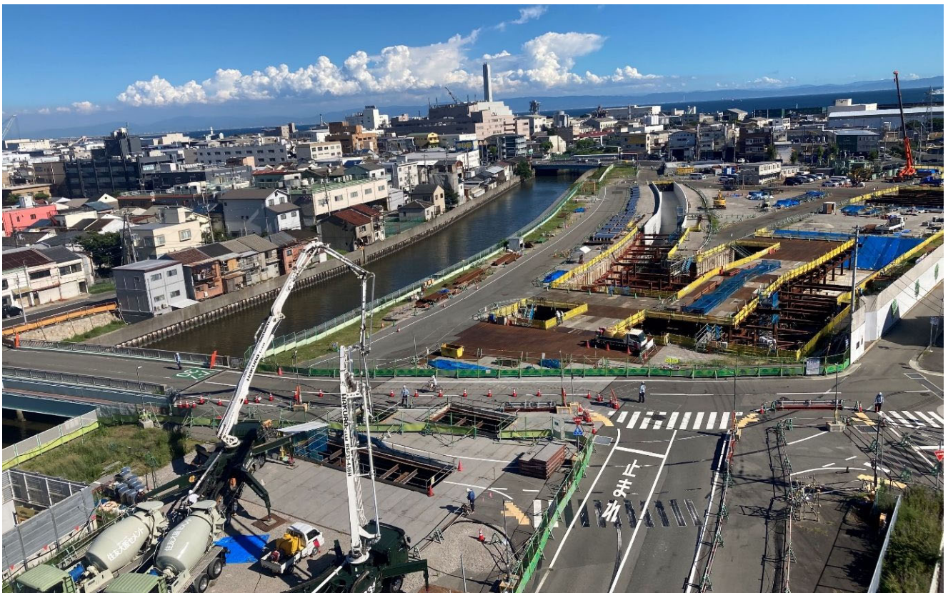
開削トンネルの施工状況（駒栄工区）
