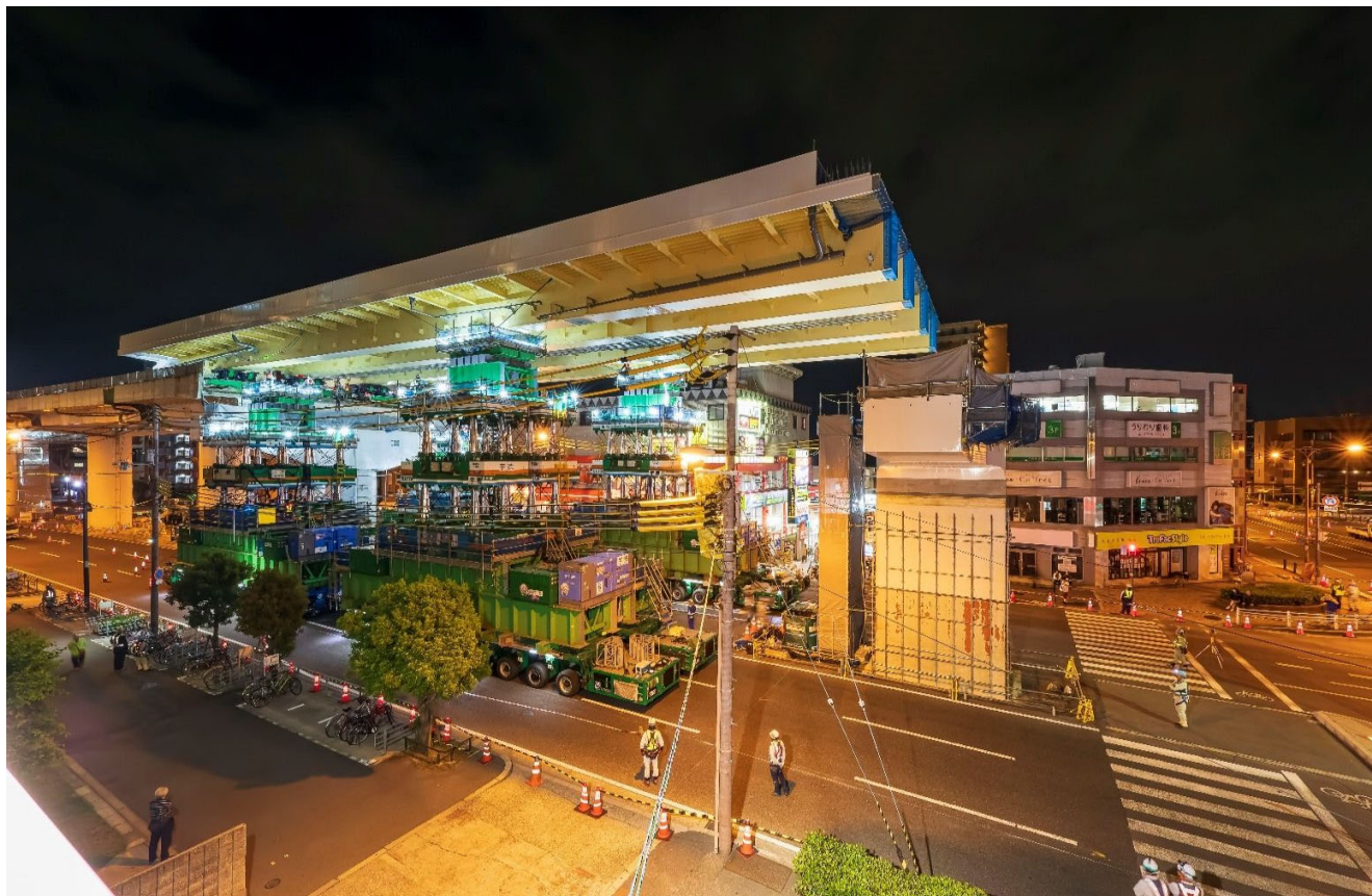
鋼製箱桁（側径間部）の架設
