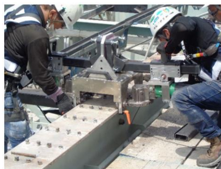
写真-3 残スタッド切断状況
