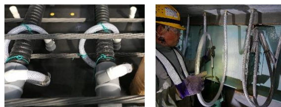
写真-6 下面グラウト治具と作業状況
