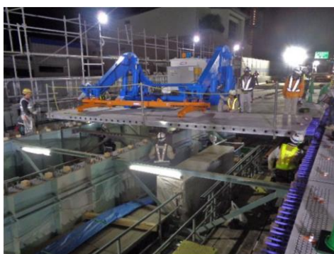
写真-4 床版設置状況
