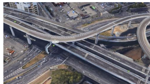
写真-7 現地状況 (取替え前)
