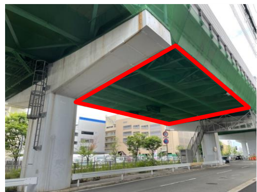
写真-2 現地状況（取替え前）
