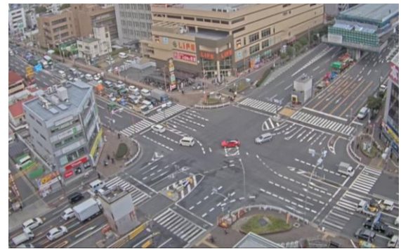
写真-13 撤去完了後の瓜破交差点
