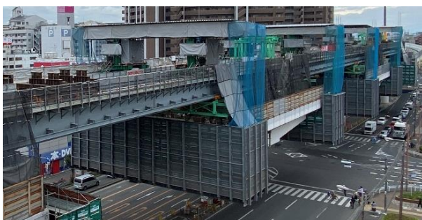
写真-7 移動作業車
