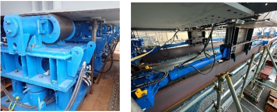
写真-12 エンドレスローラー（左） 牽引用の油圧ジャッキ（右）
