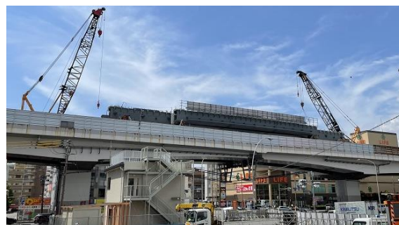
写真-5 仮設桁のクレーン架設
