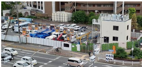
写真-14 情報館と工事ヤード
