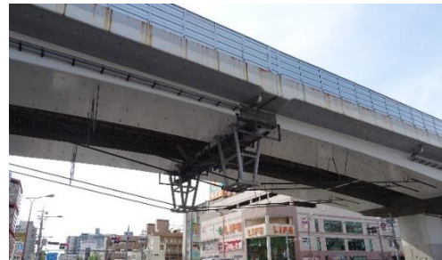
写真-4 下弦ケーブルとストラット
