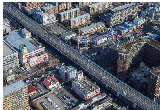
写真-1 喜連瓜破橋と周辺状況（2022 年 1 月） て報告する。
