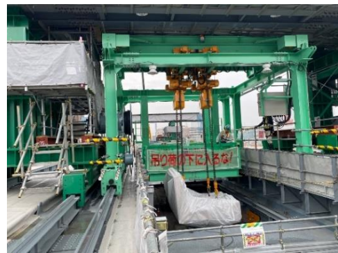
写真-9 運搬台車（Co塊の揚重中）
