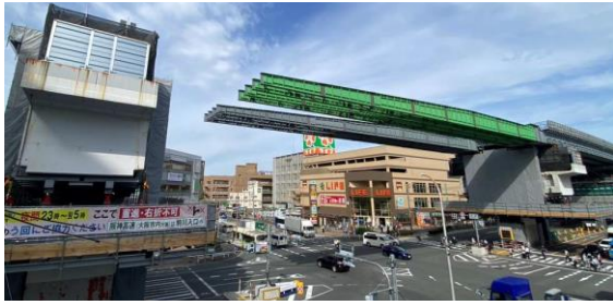
写真-11 交差点上で張出し状態の手延べ桁
