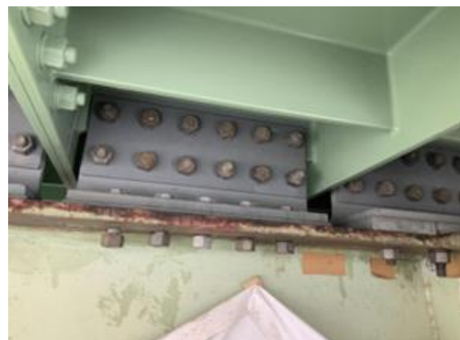
(d) 高力ボルトの締結
