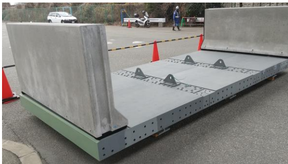
写真-3 正曲げ区間の架設ブロック
