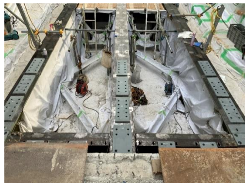
(b) 高力ボルト孔の削孔
