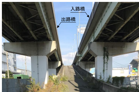
写真-2 試験施工前の状況 (P4 側より)
