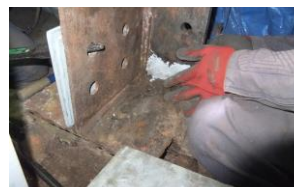
(a) 腐食部へのエポキシ樹脂充填
