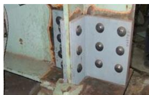
(b) 当て板補修完了
