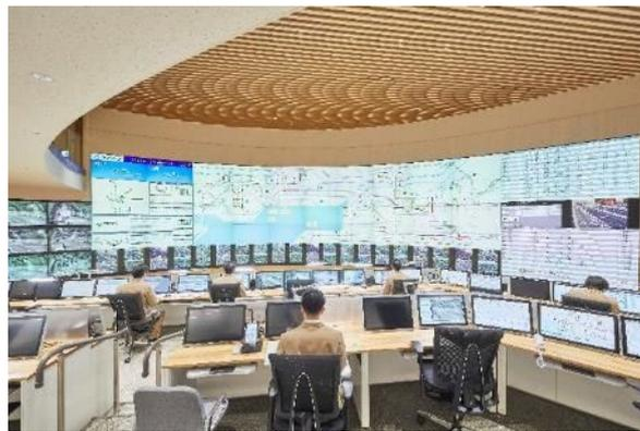
GP を中心に操作卓を機能的に配置し、階段上のレイアウトとすることで後方からの視認性を確保、各階の後方部分にも操作卓を配置し、運用動線を意識した。
