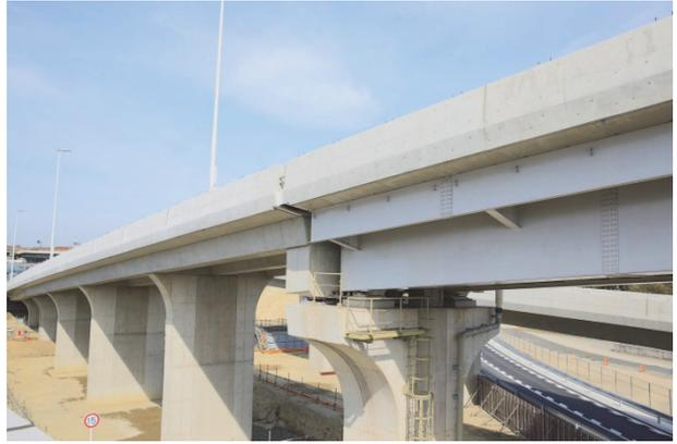
写真-8 鋼橋とコンクリート橋掛違い部景観対策
