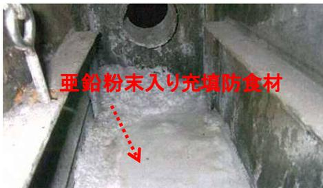
写真-3 電気防食工法（亜鉛粉末入り充填防食材）
