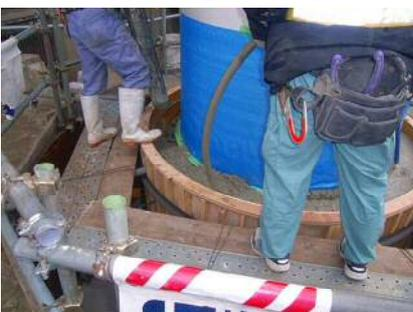
写真-10 根巻きコンクリート打設
