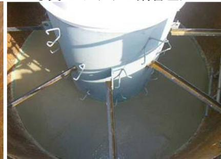
写真-9 環状コンクリート打設完了
