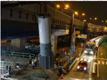
写真-7 鋼製橋脚架設
