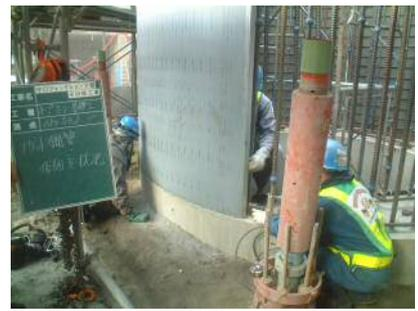
写真-3 ソケット鋼管据付
