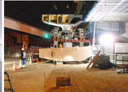
写真-12 鋼製梁架設
