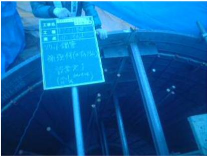
写真-4 ソケット鋼管歪み防止材
