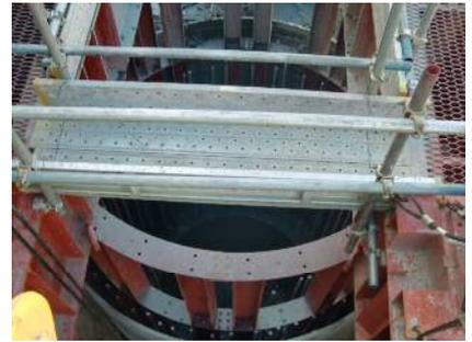
写真-6 ソケット鋼管圧入
