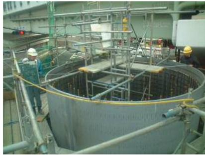
写真-5 ソケット鋼管据付
