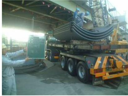
写真-2 ソケット鋼管現地搬入
