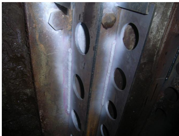
図-12 浸透探傷試験状況
