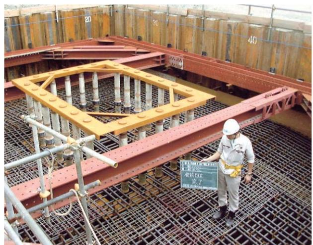
写真-1 アンカーフレームとフーチングの
