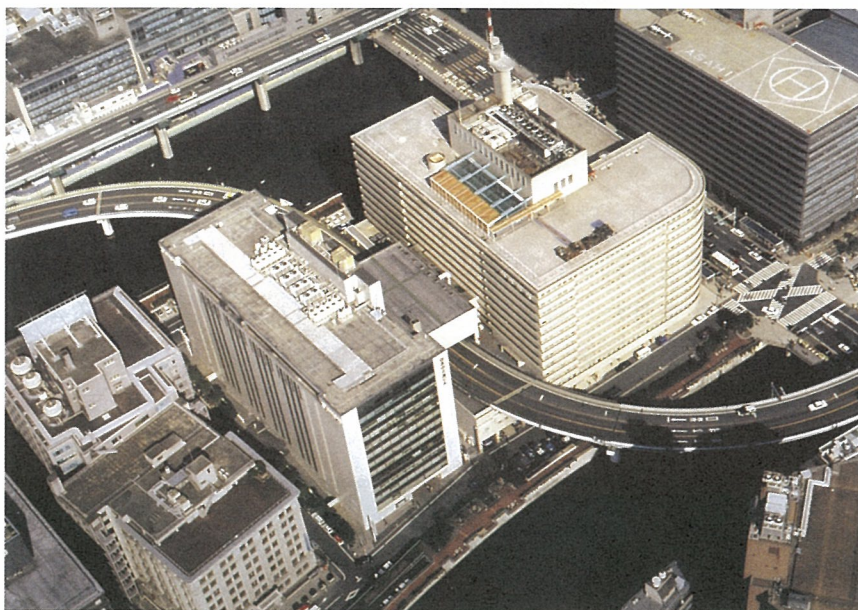
写真-6 中之島の“S字橋”
