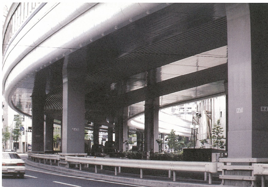
写真-10 弁天高架橋
