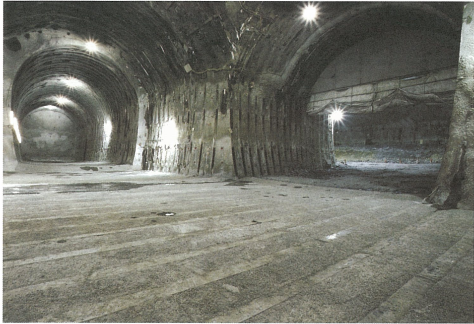
写真－8 新十条通トンネル（シールドマシーン転回部）
