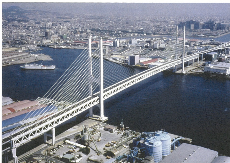
写真-2 東神戸大橋(鋼斜張橋)
