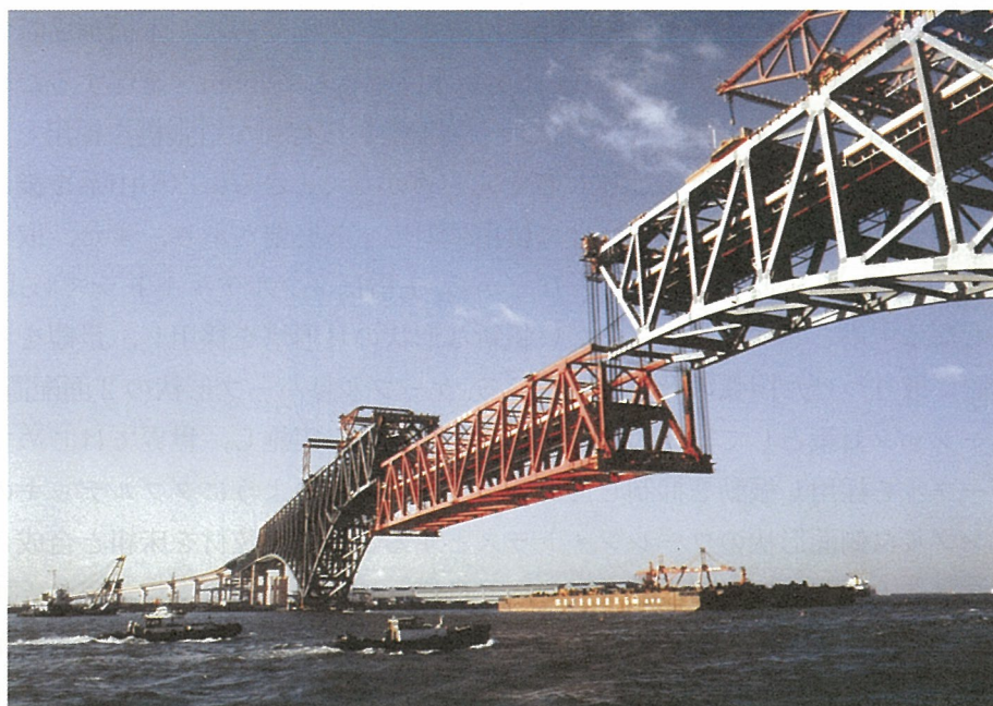
写真-1 港大橋中央桁部の一括架設(ゲルバートラス橋)
