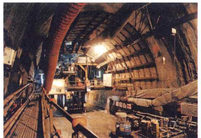
写真-2 パイプルーフ施工基地
