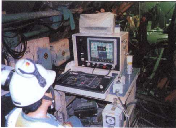
写真-4 掘進機運転状況
