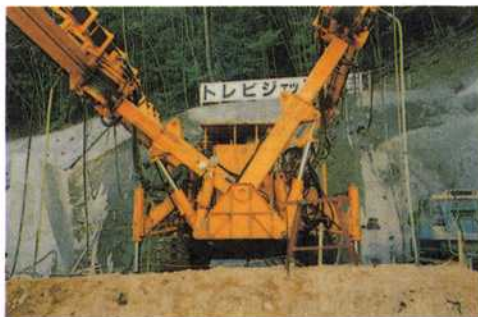
写真-1 施工状況
