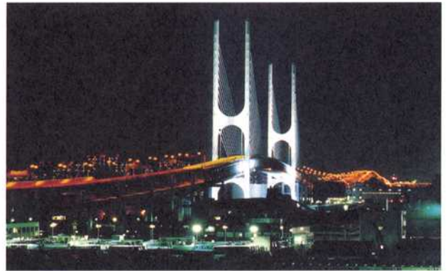
写真-6 東神戸大橋
