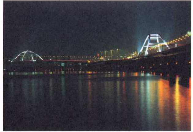
写真-4 中島川橋と神崎川橋
