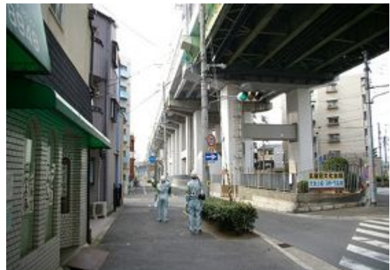
日常点検（路下）
