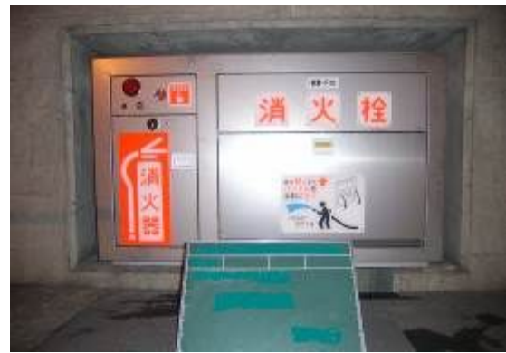
消火栓 取換後
