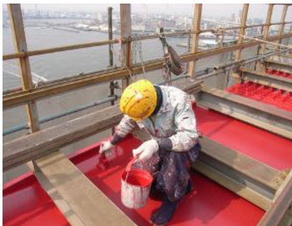
塗装塗替工事
