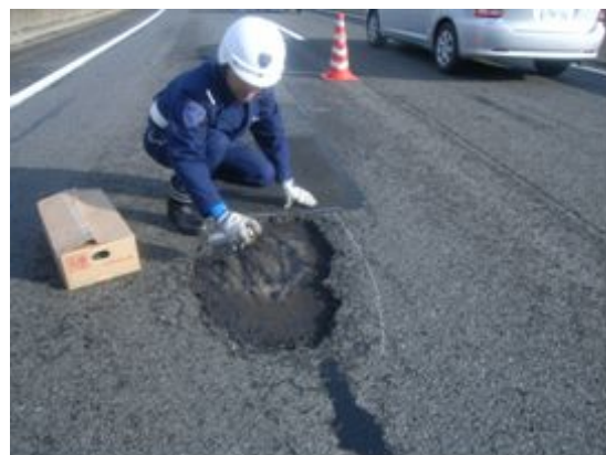
ポットホールの緊急対応の様子
