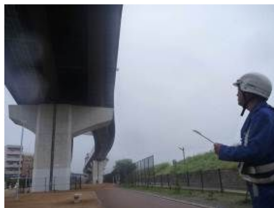
高架下点検及び構造物日常点検
