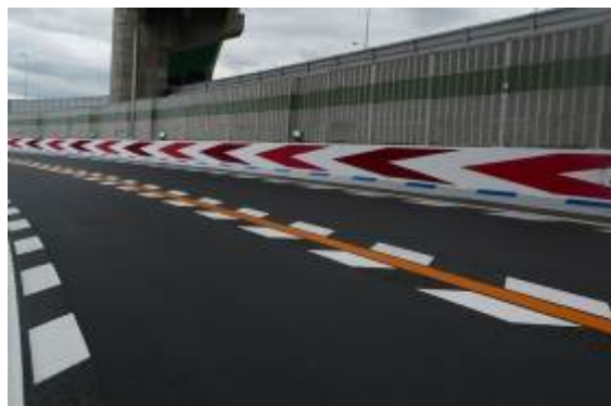
滑り止め舗装
