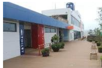
ウッドデッキの設置
