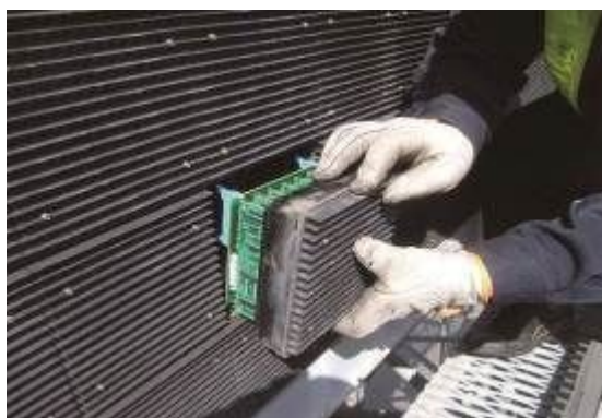
日常補修（情報板表示部交換）
