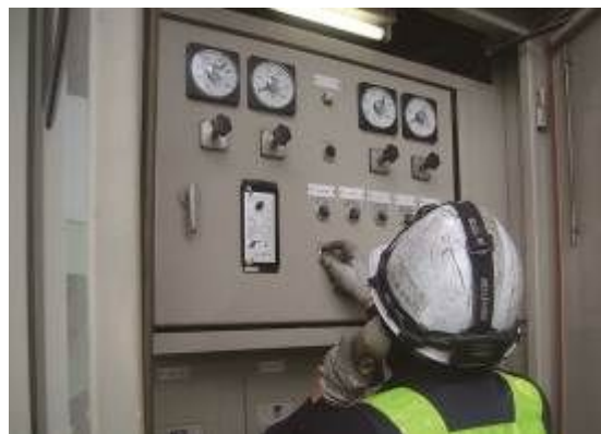
定期点検（変電塔）
