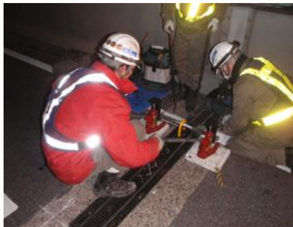
伸縮継手補修工事
