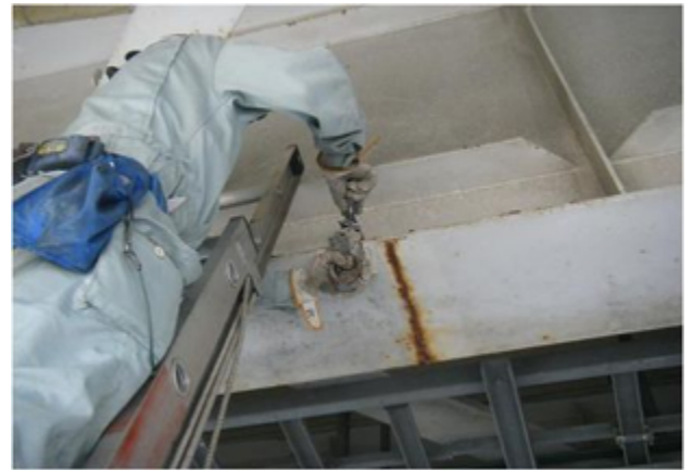
点検時応急措置(塗装補修)
