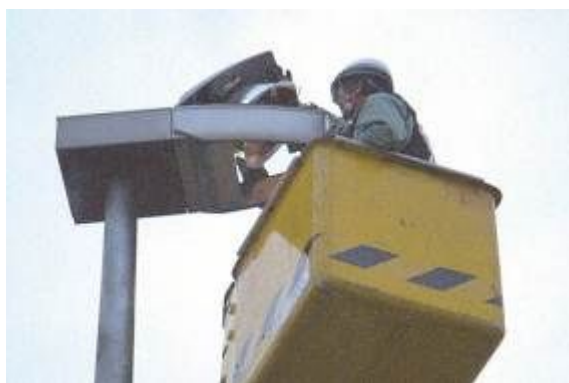
日常補修（照明ランプ交換）
