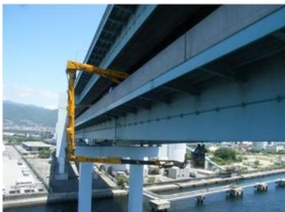
橋梁定期点検
