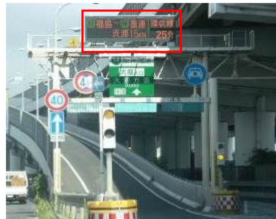
道路情報板取換後
