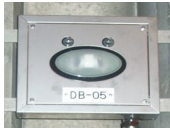
火災検知器 取換後
