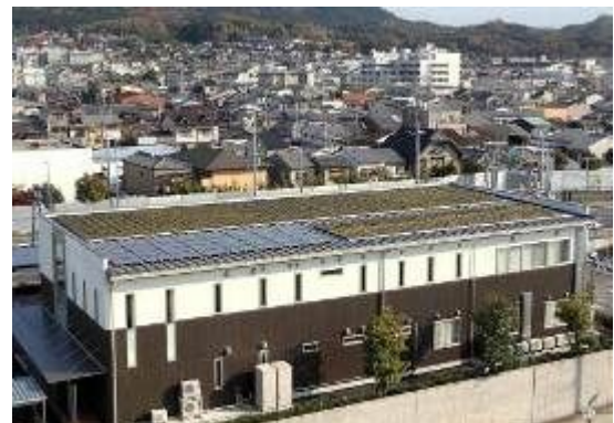
屋上緑化の設置状況
