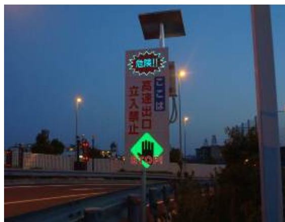
夜間視認性の高い誤進入防止注意喚起看板の設置
