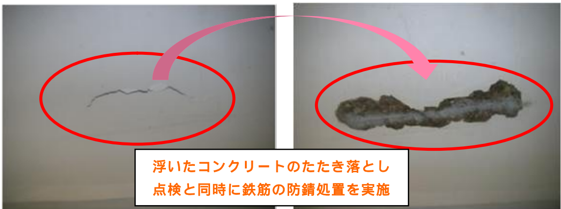
点検時応急措置(はく離、遊離石灰の補修)
