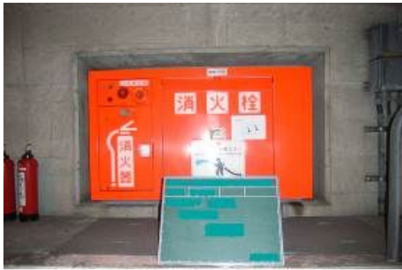
消火栓 取換前
