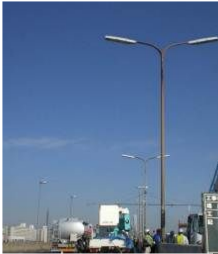
照明柱取替前
