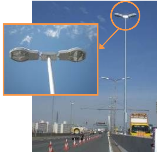
照明柱取替後
