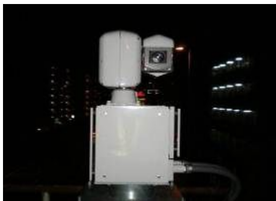
交通流監視カメラ取換後
