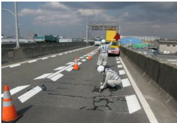
日常点検（路上）
