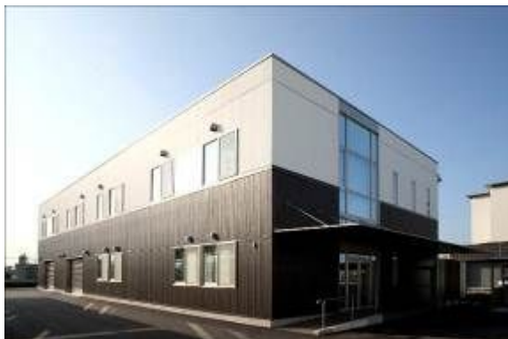
京都管理基地事務所 外観
