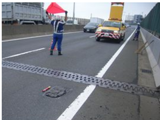
ポットホールの緊急対応の様子
