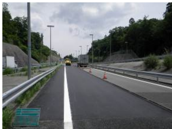
路面損傷状況(施工後)
