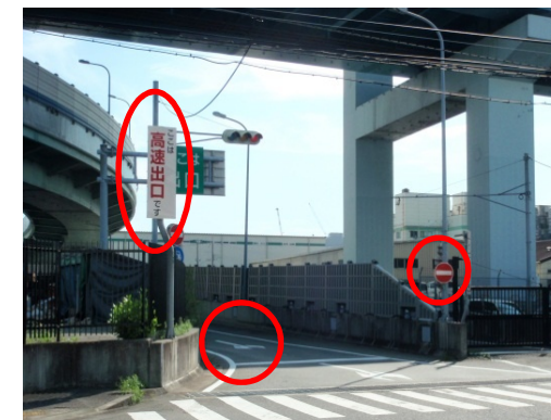
注意喚起看板・路面表示
