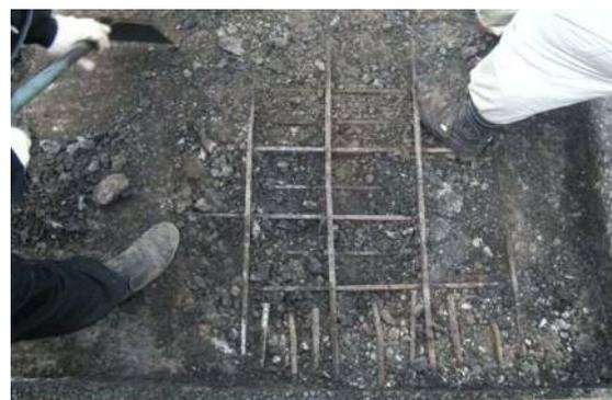
写真 損傷したRC床版(上面)
