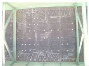
鋼板接着RC床版
