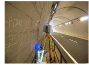
トンネル内空面
