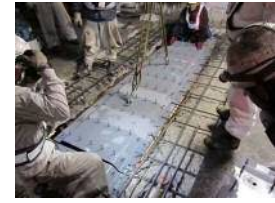
実現場での施工状況
