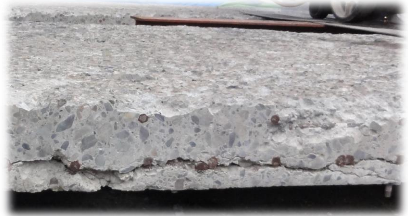
切断面の水平ひび割れ
