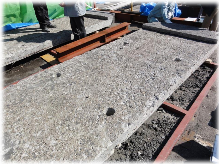
舗装撤去後のRC床版
