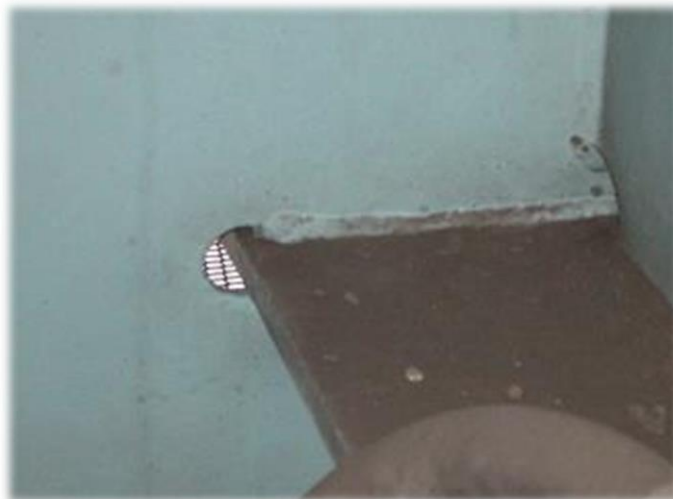
横桁下フランジ貫通タイプ
