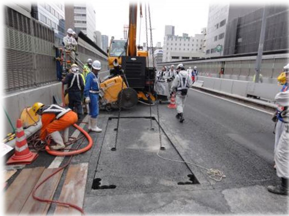
実橋からのRC床版の切り出し
