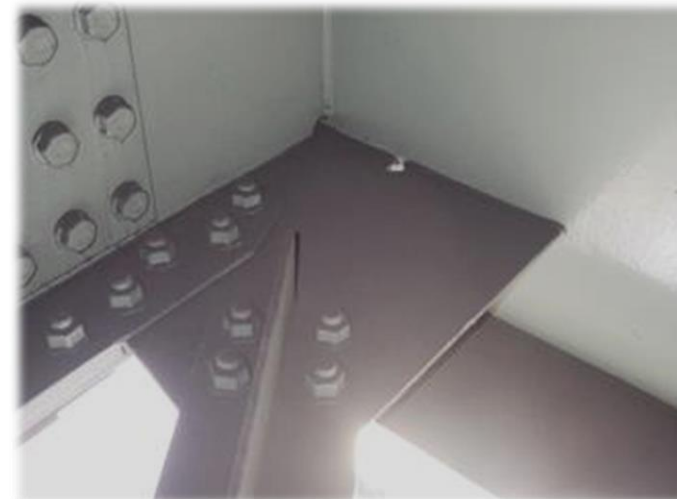
面内ガセット継手タイプ
