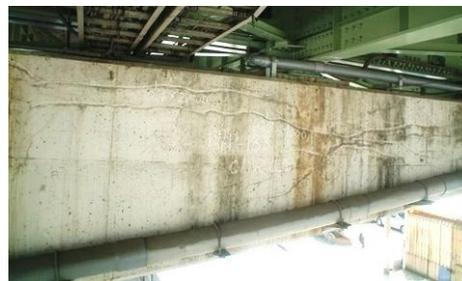
ASRによるコンクリート橋脚梁のひび割れ
