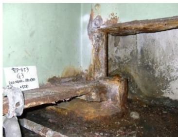
鋼桁端部の腐食
