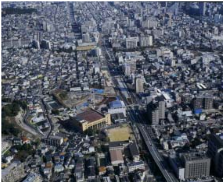
南伸部区間の現状(神戸長田ランプ付近)
