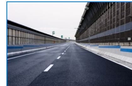
(深江付近に設置した水平標示)
